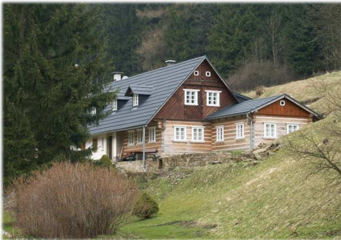
Obr. č. 2 Zrekonstruovaný roubený dům ve Vápence
