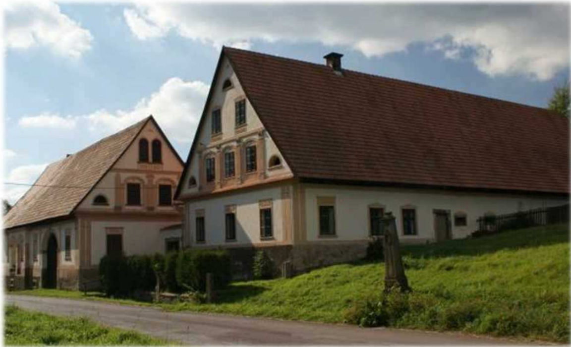
Obr. č. 1 Statek broumovského typu v Heřmánkovicích
